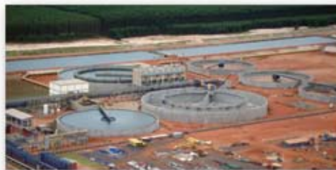
TRATAMENTO DE AFLUENTES
