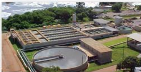
TRATAMENTO DE ÁGUA
