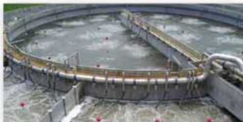
TRATAMENTO DE EFLUENTES
