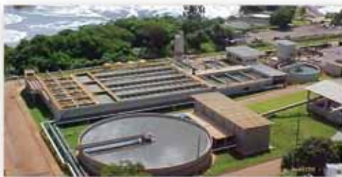
TRATAMENTO DE ÁGUA
