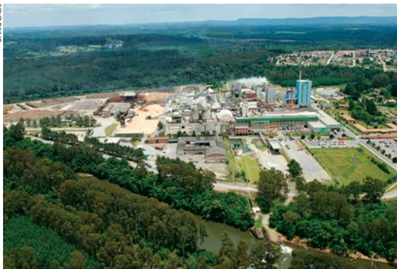
Unidade de Otacílio Costa da Klabin comemora os resultados positivos da substituição da caldeira a óleo pela de biomassa
