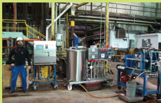
Primeira instalação do processo de LignoBoost está em fase de start up na fábrica de Domtar Plymouth, nos Estados Unidos
