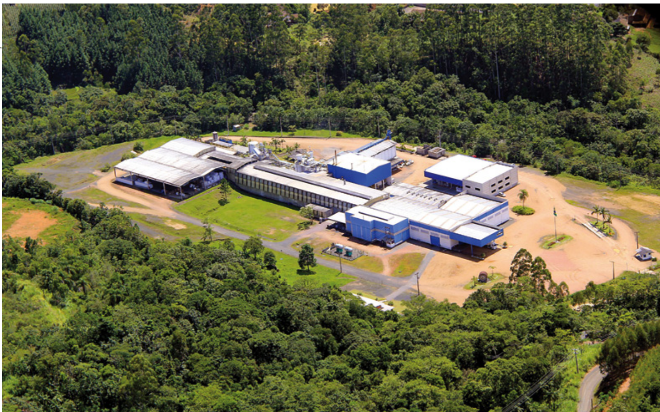
Vista geral da fábrica da BN Papeis, localizada no município de Benedito Novo (SC). A empresa, de 105 funcionários, está entre as quatro Melhores Empresas para se Trabalhar, segundo pesquisa do Instituto Great Place to Work
