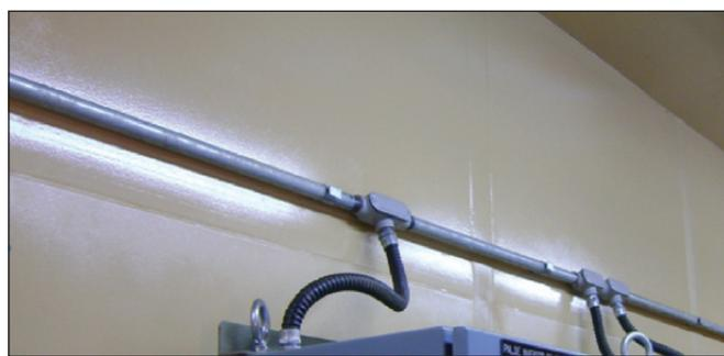
**Figura 3.** Exemplo de instalação PROFIBUS DP, cabos da rede separados dos cabos de potência
