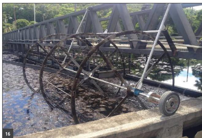
**Figura 16.** Sistema quebra-floco acoplado ao decantador secundário da ETE da CENIBRA
