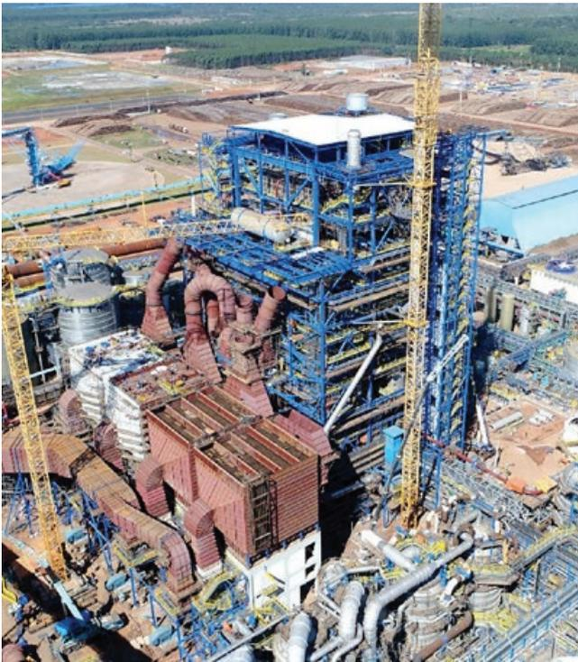
Ao elevar essa disponibilidade, entre várias ações realizadas destaca-se a maior utilização na fornalha baixa de ligas especiais (Sanicro), que conseguem suportar severas condições de operação da caldeira. Essa metalurgia diferenciada, ou seja, mais resistente, proporciona o aumento das condições operacionais de uma caldeira desse porte.
