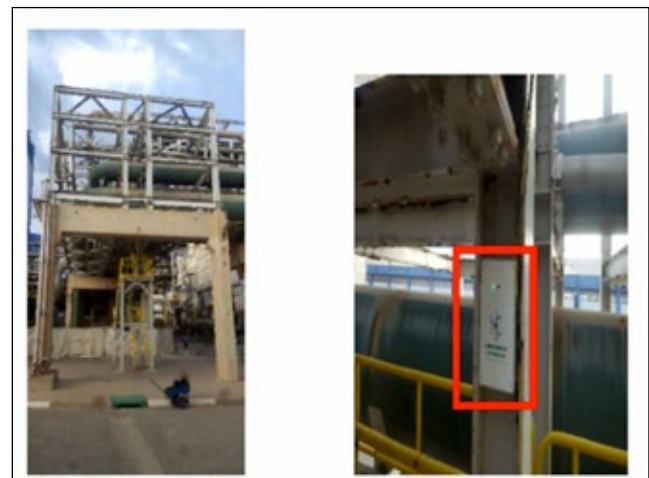
Figura 2. Instalação do anodo eletrônico no pipe rack linha 2
