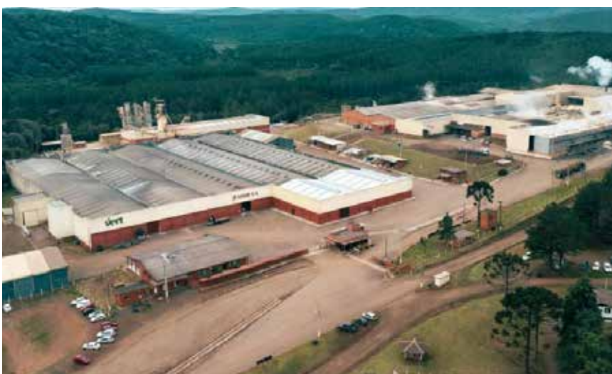
O complexo fabril situado em Caçador-SC tornou-se responsável pela produção de madeira serrada e beneficiada, paletes, painéis, molduras, portas, kits de portas, modulados, papel para embalagens, chapas e caixas de papelão ondulado
