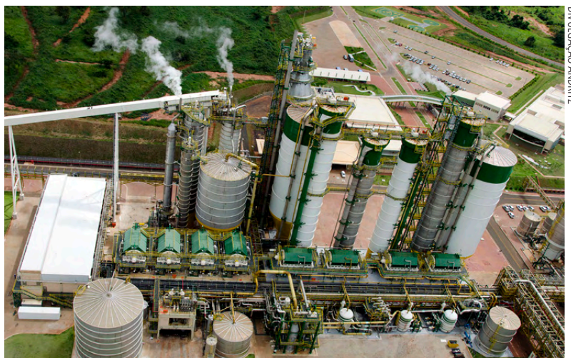
Eldorado Brasil contou com a Andritz no fornecimento do pátio de madeira, da linha de fibra, da planta de secagem/enfardamento e da planta de licor branco
