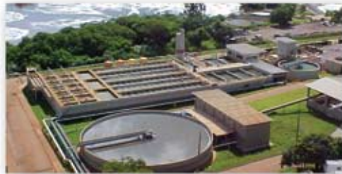
TRATAMENTO DE ÁGUA
