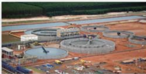
TRATAMENTO DE EFLUENTES
