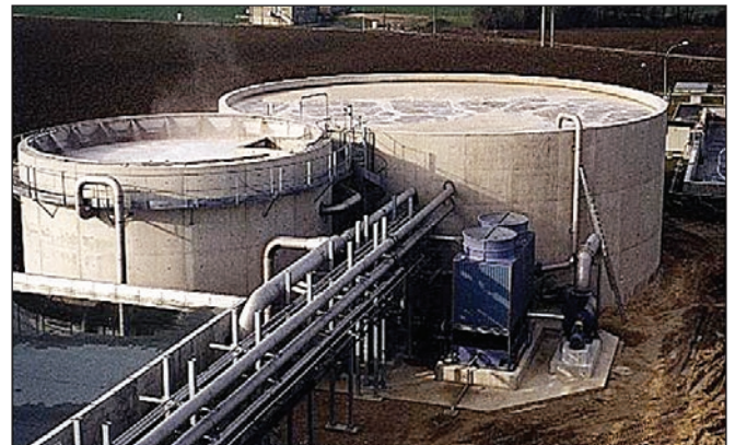
Figura 6. Estação de Tratamento utilizando o processo BAS com reator MBBR (esquerda) seguido de processo de lodos ativados (direita)
