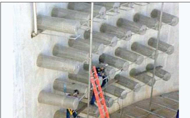
Figura 4. Sistema de peneiras na saída do reator MBBR
