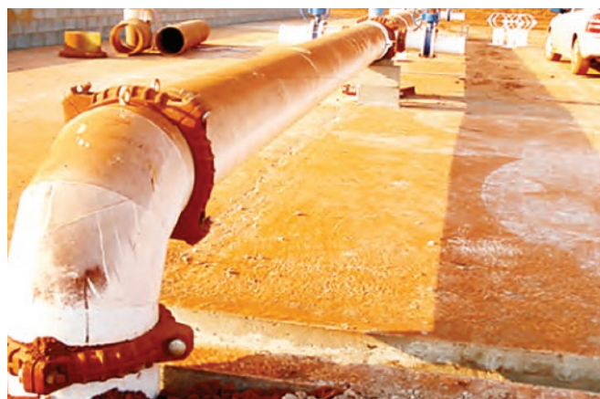
Figura 5. Tubos revestidos interna e externamente e unidos por acoplamentos
