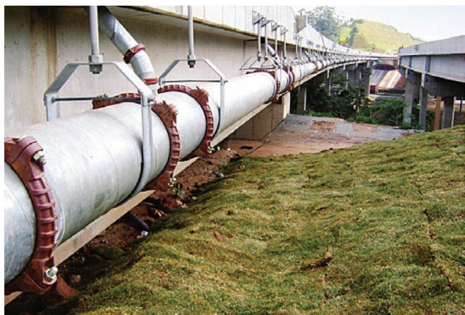
Figura 4. Uso da solução em obras de infraestrutura
