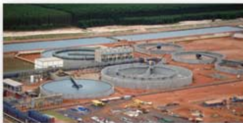
TRATAMENTO DE AFLUENTES
