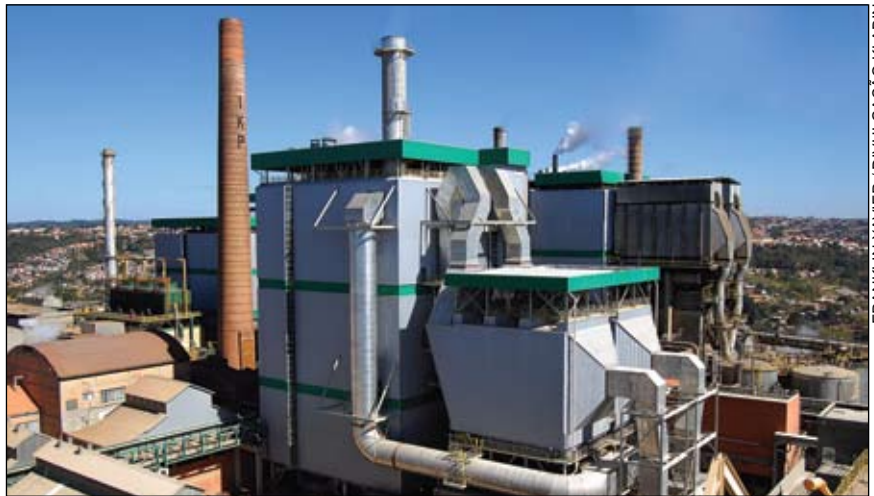
Novas caldeiras funcionam com pressão de 100 bar, uma das maiores no setor
