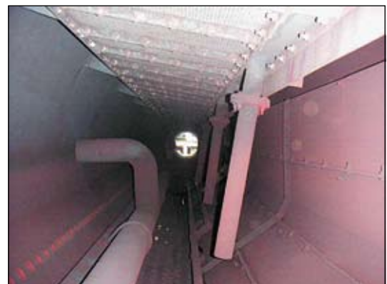
Figura 9. Internos do balão. Atentar quanto a suas fixações após um ESP / Figure 9. Drum internal parts. Pay attention to their fastenings after an ESP
