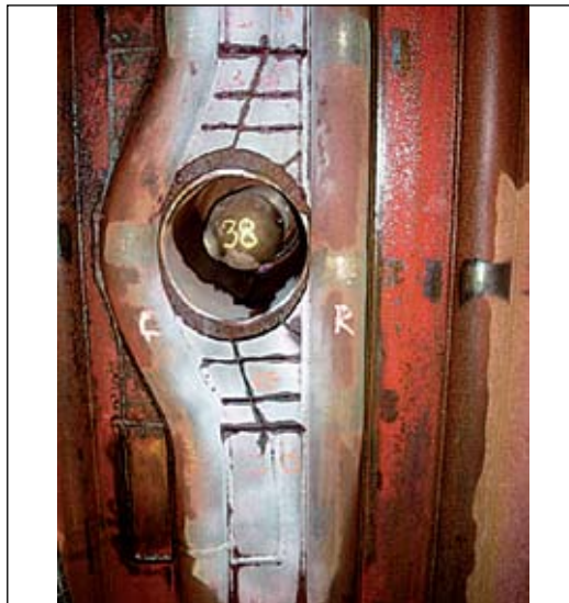
Figura 12. Abertura para soprador de fuligem. Têm-se aqui elementos concentradores de tensões, requerendo inspeção cuidadosa nesta ocasião / Figure 12. Opening for soot blower. There are here stress concentrating elements, requiring careful inspection on that occasion
