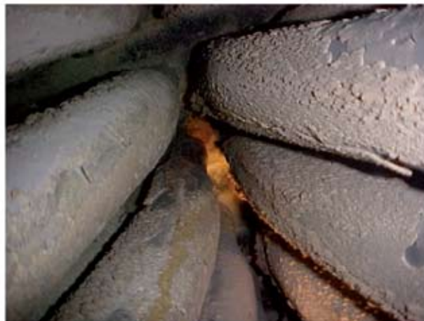
Figura 3 e detalhe auxiliar. No teste hidrostático preliminar, verificar possíveis vazamentos nos assentos dos tubos do bank junto aos balões / Figure 3 and auxiliary detail. Check possible leakages in the seats of the bank tubes next to the drums in the preliminary hydrotest
