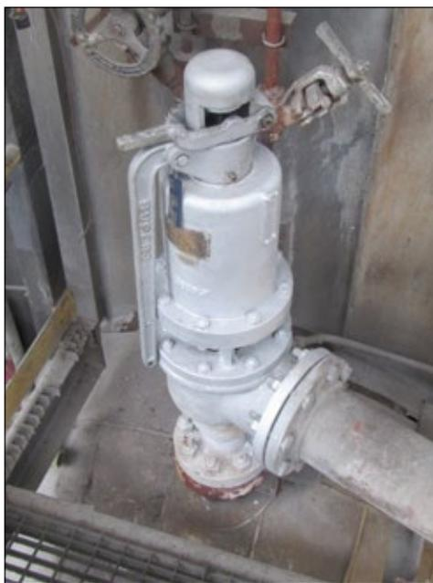
Figura 1. uma PSV do balão de uma caldeira de força
