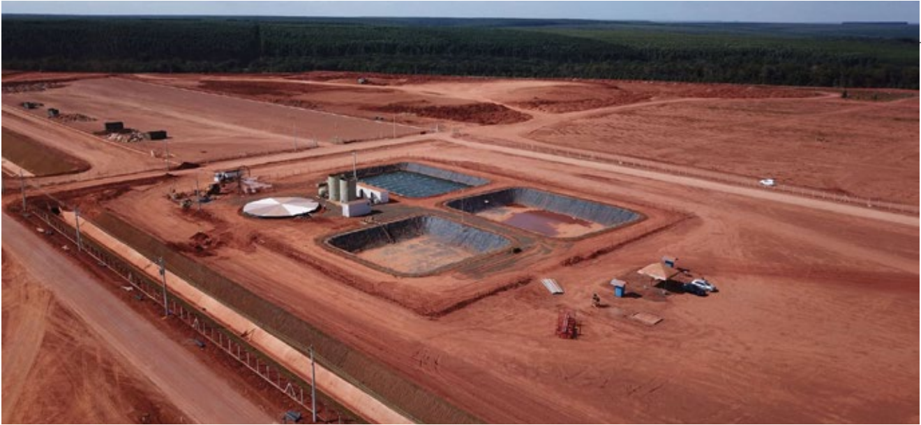
Atualmente, está em andamento o estaqueamento e as fundações das áreas de processo, BOP, Captação de Água e Tratamento de Água e Efluentes
