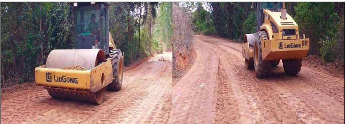
**Figura 18. Compactação com rolo liso para acabamento**
