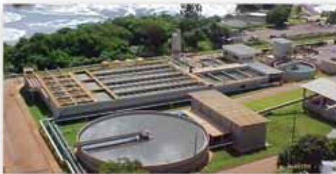
TRATAMENTO DE ÁGUA
