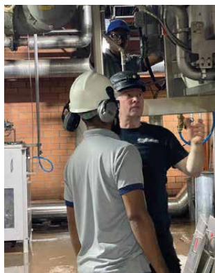
Técnicos em momento de instalação
