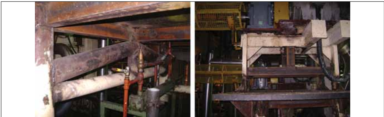
Figura 15. Modificações feitas na estrutura / Figure 15. Modifications made in the structure
