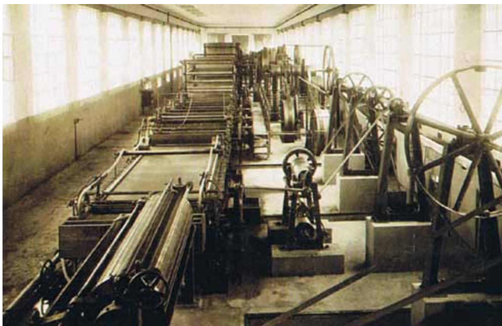
Figura 3. Acionamento de uma máquina de papel de 185 cm de largura, em 1911 / Figure 3. Drive of a 185 cm wide paper machine in 1911
