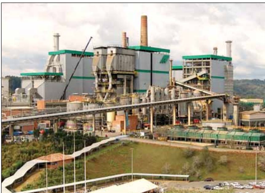
Caldeira de biomassa da Klabin no Paraná agora aproveita resíduos vegetais de toda a região para gerar energia
