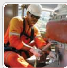
Serviços de montagem e reparo
