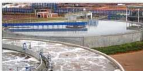
TRATAMENTO DE EFLUENTES
