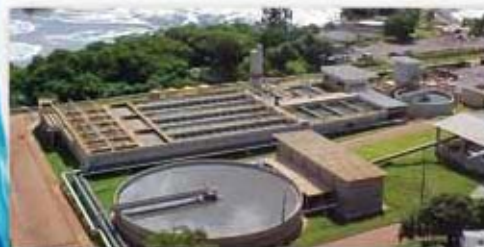
TRATAMENTO DE ÁGUA
