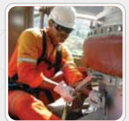
Serviços de montagem e reparo
