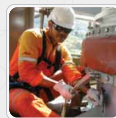
Serviços de montagem e reparo
