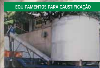
EQUIPAMENTOS PARA CAUSTIFICAÇÃO
