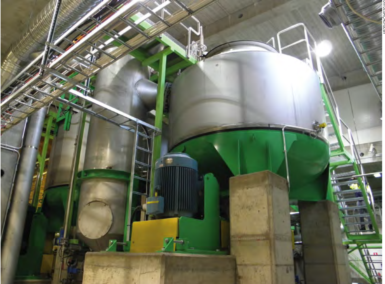
Figura 2. Clarificador e pulper secundário
