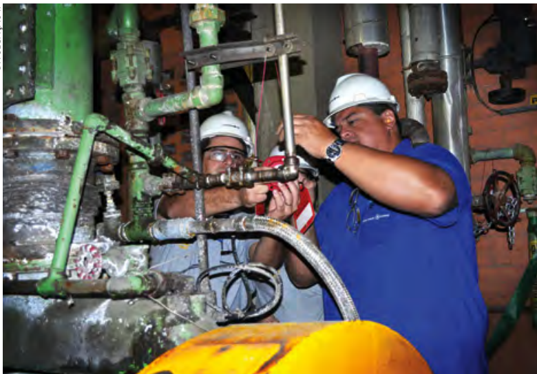
Prática de segurança: Profissional da IP realiza o bloqueio (lockout) de todas as formas de energia do equipamento antes de começar a manutenção
