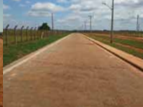
Terminal multimodal Aparecida do Taboado, MS
