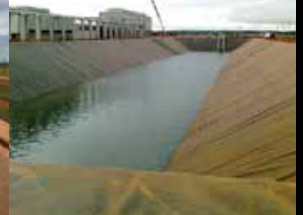
Lagoa de emergência e aeração Três Lagoas, MS
