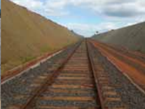
Terminal multimodal Aparecida do Taboado, MS
