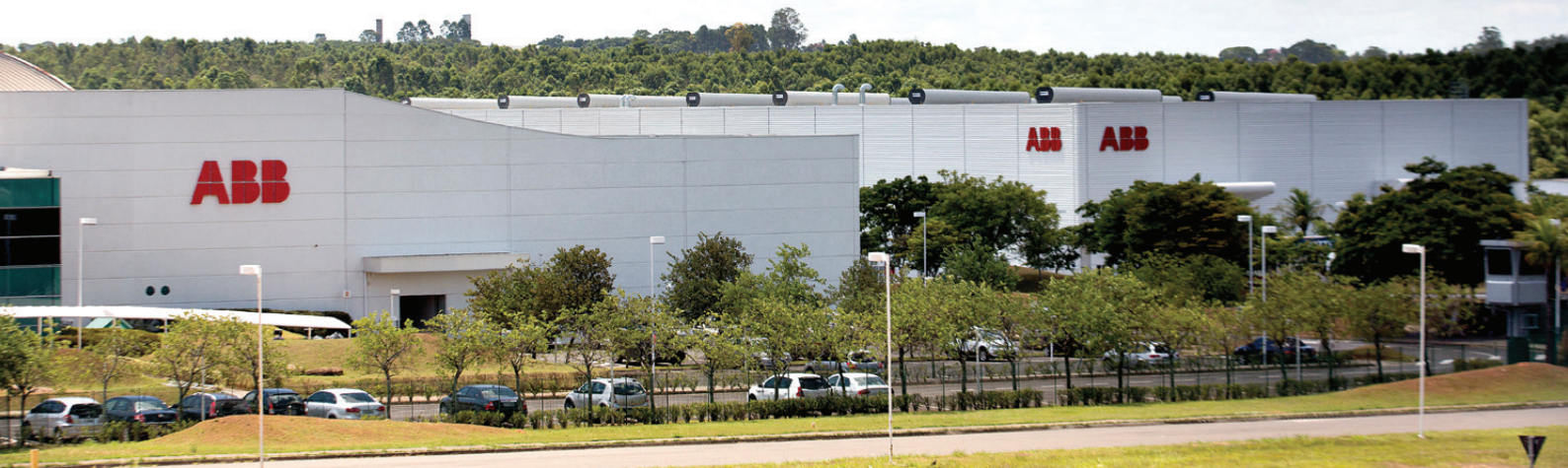
Complexo em Sorocaba (SP) integra a primeira fábrica de eletrocentros do Grupo ABB
