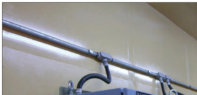
**Figura 3.** Exemplo de instalação PROFIBUS DP, cabos da rede separados dos cabos de potência
