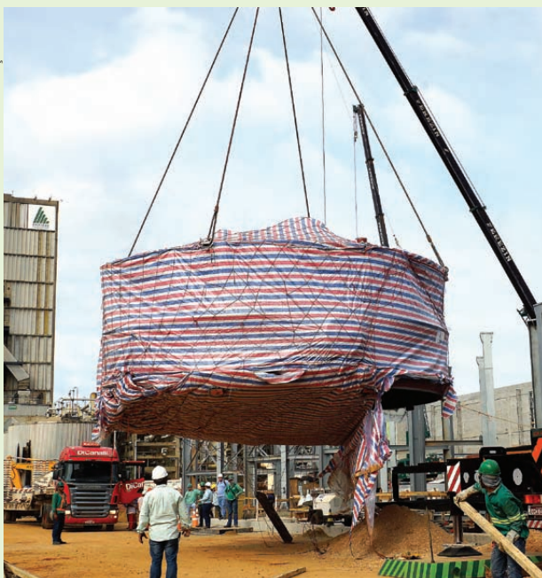
Equipe trabalhou na montagem da planta de evaporação em maio último
