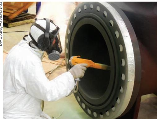
Cilindros tensionadores e pressionadores com revestimento anticorrosivo aplicado pela Metalcoating
