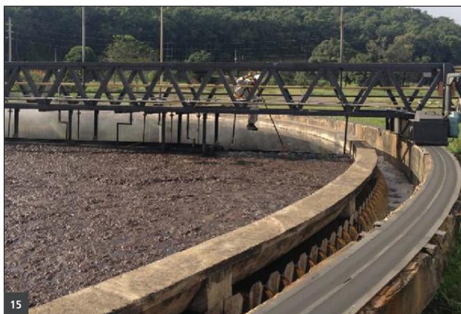
**Figuras 14 e 15.** Flotação de lodo observada na superfície dos decantadores da linha de tratamento 2 e coleta manual do lodo flutuado
