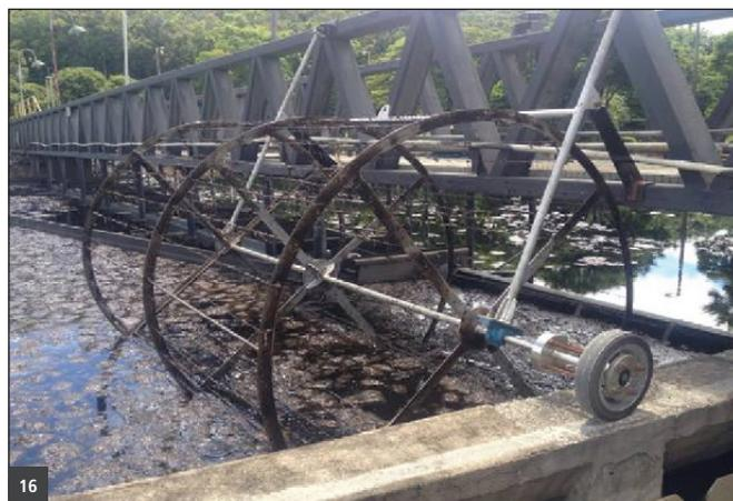
**Figura 16.** Sistema quebra-floco acoplado ao decantador secundário da ETE da CENIBRA
