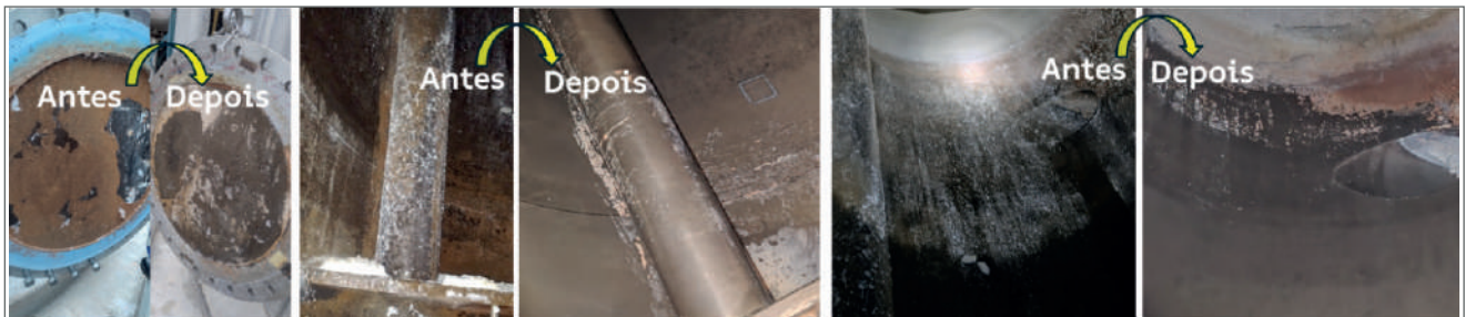
Figura 15. Limpeza química do tanque de filtrado do estágio Dhot
