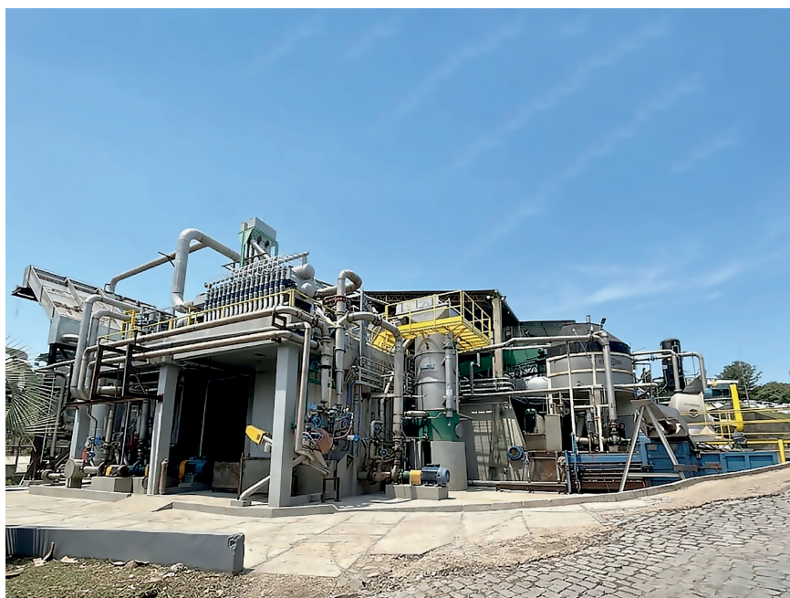
Etapas de preparação de massa e purificação das fibras após novo investimento
