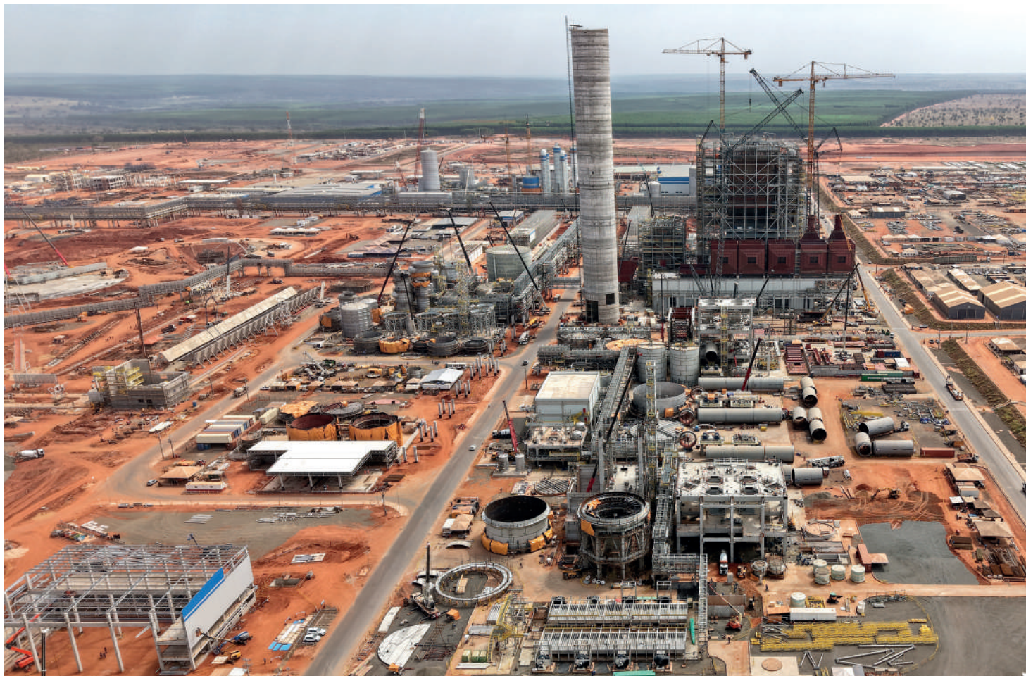
Foto aérea do canteiro de obras do Projeto Sucuriú em Inocência-MS
