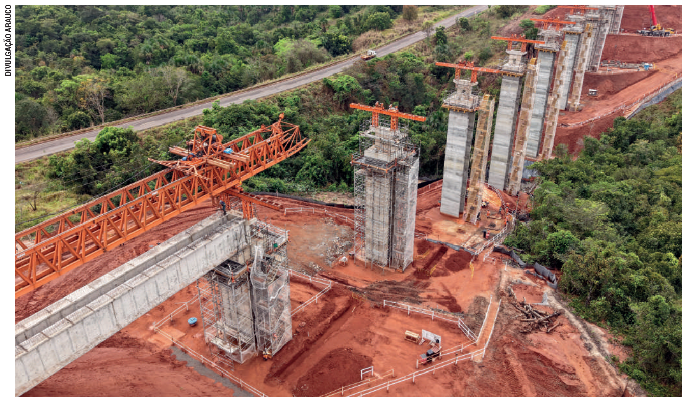
Avanço da construção da ponte ferroviária de 270 metros sobre o córrego São Mateus
